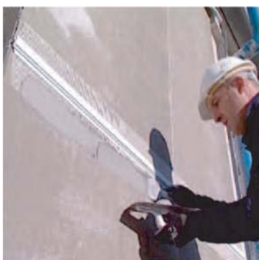
Ugradnja profila za dilatacione fuge, koje služe da prime uticaje temperaturnih razlika.
