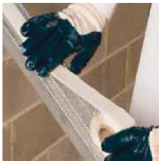
Rigips UD-profilu oblažu se zvučnoizolacionom samolepljivom trakom.
