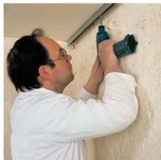
Montaža Rigips UD-profila na pod i plafon.
