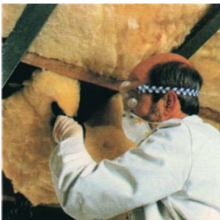
Između rogova se postavlja oko 15 cm Isover mineralne vune i parna brana.
