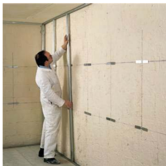
Rigips distanceri montiraju se na zid.
