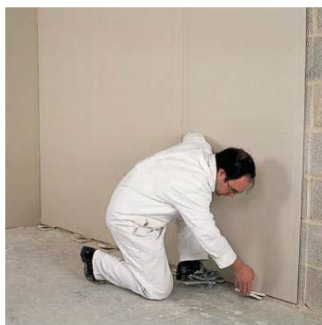
Nakon lepljenja ploča se malo izdiže da bi se ubacile podloške od 10 mm.
