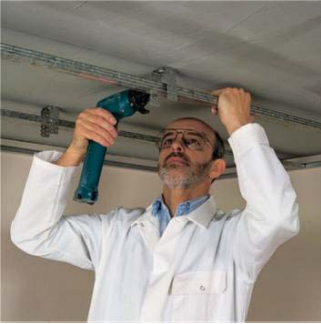
Profil se šrafe za distancer vijcima sa širokom glavom.
