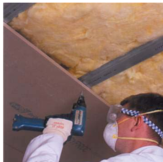
Rigips ploče u jednom ili dva sloja montiraju se na profile.
