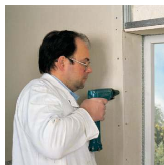
Otvori za vrata i prozore se posebno ojačavaju profilima. Ploče se šrafe vijcima, a zatim se gletuju spojevi.
