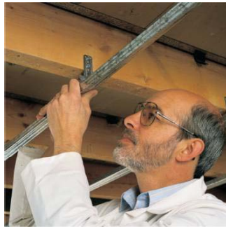
Rigips CD-profil postavlja se na držače na rastojanju od 50 cm.
