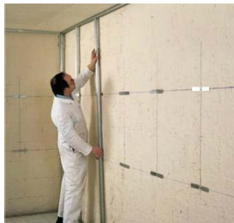
Rigips distanceri i zidni profili montiraju se na zid.
