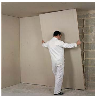
Rigips ploče, sa dužinom koja odgovara spratnoj visini, lepe se na zid.
