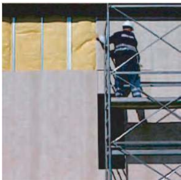
Montaža spoljne obloge od Aquaroc ploča preko metalnih profila.
