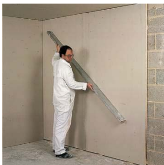
Nakon lepljenja ploče se ravnaju dugačkom ravnjačom koja zahvata tri ploče.
