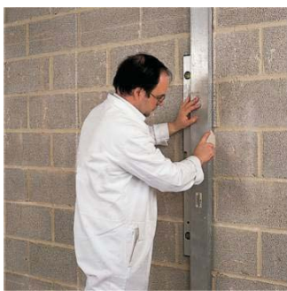
Nakon provjere ravnine zida, obeležavaju se mesta za nanošenje lepka.
