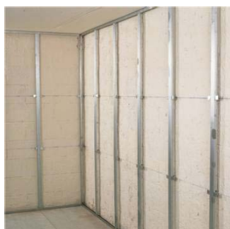
Nakon montaže Rigips potkonstrukcije, provlačimo instalacije.
