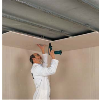
Nakon montaže instalacija i Isover izolacije, montiraju se ploče sa smaknutim spojevima.
