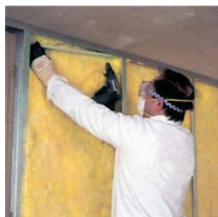
Isover mineralna vuna postavlja se u šupljinu zida, za poboljšanje zvučne i termoizolacije.
