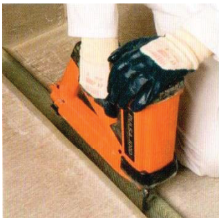
UW-profilu montiraju se na pod i plafon.
