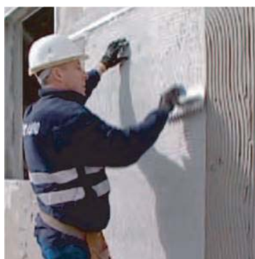
Finalno malterisanje sa Aquaroc Skim malterom ili fasadnim lepkom, mrežicom i malterom.
