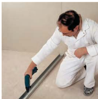
Obloženi su samolepljivom trakom za zvučnu izolaciju,
