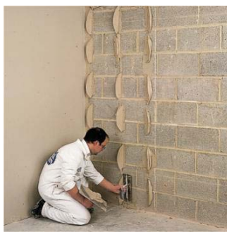
Lepak u vidu pogača nanosi se u tri vertikale za 12,5 mm ploče i četiri vertikale za 9,5 mm ploče.
