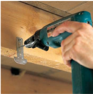
Na drvenu konstrukciju šrafe se držači od 8cm vijcima od 25 mm.
