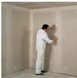
Ispunjavanje i gletovanje spojeva se vrši primenom bandaž traka.
