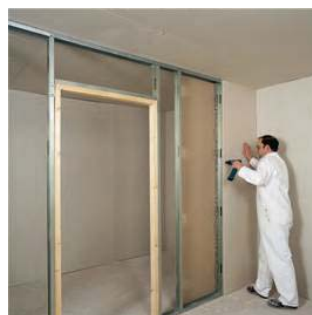
Zatvaramo zid slojem ploča sa druge strane i počinjemo bandažiranje i gletovanje.
