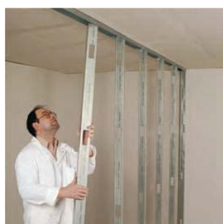
CW-profilu se utaknu između UW-profila na rastojanju od 60 cm.
