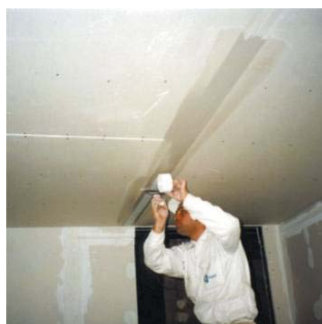
Bandažiranjem trakama i gletovanjem ispunama Standard ili Super formira se gotov plafon.
