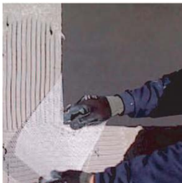
Ojačavanje uglova otvora sa mrežicom i malterom.
