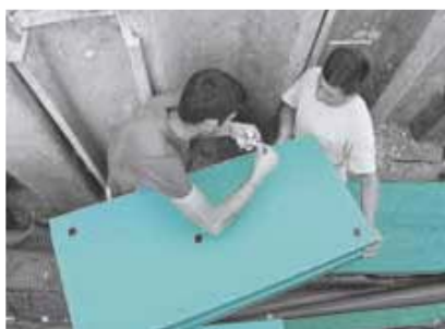
Lepjenje termoizolacije FIBRANxps 300-L na hidroizolaciju podrumskog zida sa upotrebom Fibranstick samolepljivih jastučića
