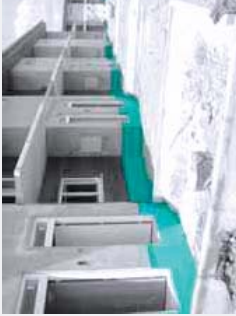
ETICS Kontaktna fasada FIBRANxps ETICS
