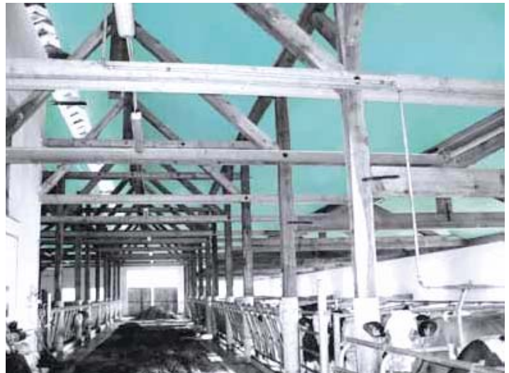
Vidljiva termoizolacija FIBRANxps MAESTRO štiti prostor od letnjeg pregrevanja i prekomernog hlađenja u zimskom periodu
