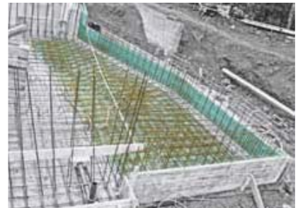
Toplotna zaštita temeljne ploče bazena sa FIBRANxps 400-L
