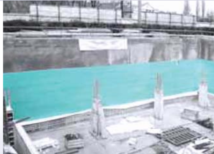
Montaža termoizolacije na zid građevinske jame u centru grada. »Inverzna gradnja«
