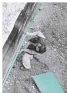
Lepjenje termoizolacije FIBRANxps 300-L na hidroizolaciju podrumskog zida sa upotrebom Fibranstick samolepljivih jastučića
