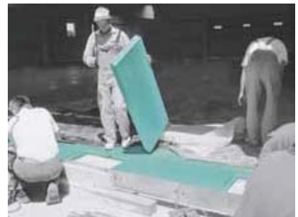
Toplotna zaštita izuzetno opterećenog poda FIBRANxps 500-L
