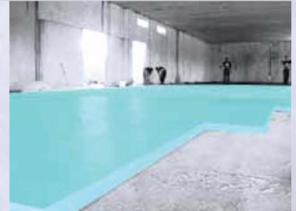
Toplotna zaštita poda skladišnog objekta sa FIBRAN xps 300-L
