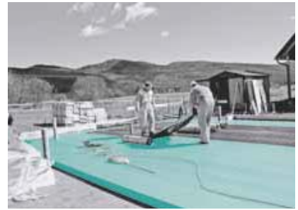
Termoizolovanje temeljne ploče niskoenergetske kuće sa FIBRANxps 400-L
