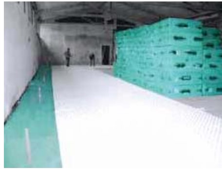
Termoizolacija FIBRANxps 300-I ispod podnog grejanja
