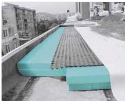
Gradnja ekstenzivnog obrnutog zelenog krova. Tremonoizolacija FIBRANxps 300-L
