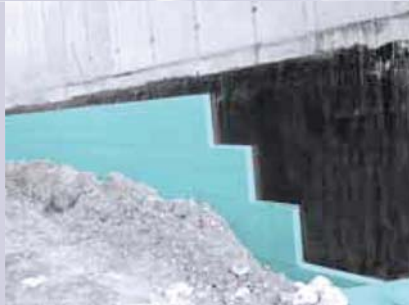
FIBRAN xps 300-L mehanička zaštita hidroizolacije i istovremeno toplotna zaštita podrumskih prostora
