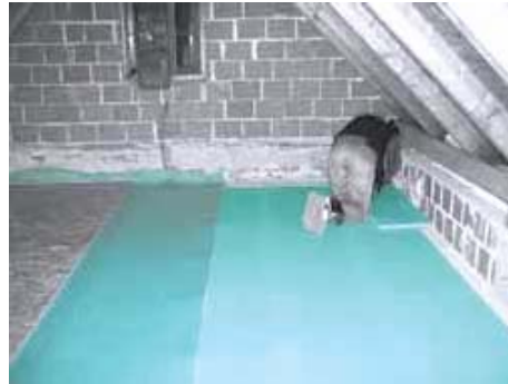
Suvomontažni pod na potkrovlju FIBRANxps 300-I i FIBRANxpe kao zvučna izolacija
