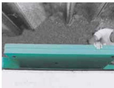
Lepjenje termoizolacije FIBRANxps 300-L na hidroizolaciju podrumskog zida sa upotrebom Fibranstick samolepljivih jastučića
